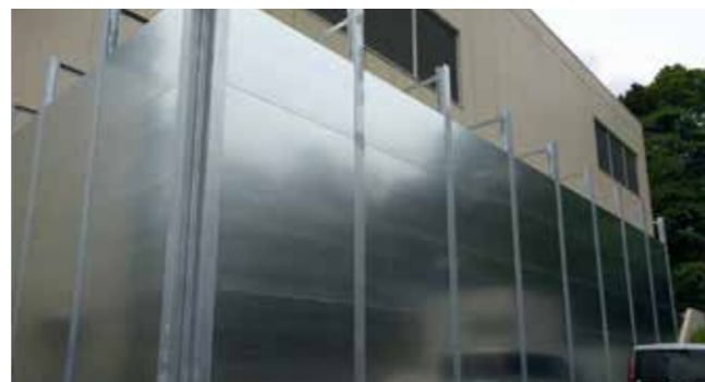
南流山変電所の防音壁
