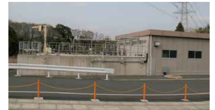
排水処理装置
