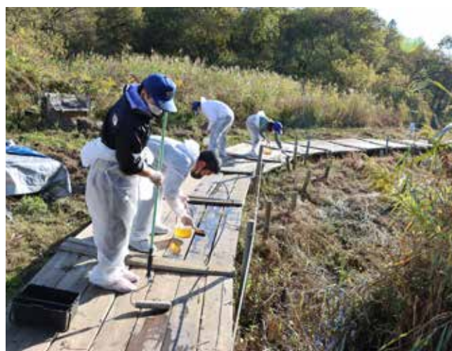
防腐剤塗装の様子
