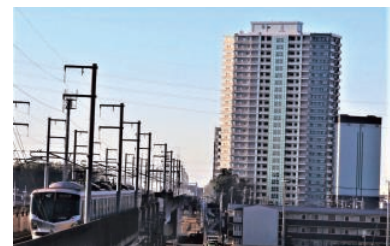
立体交差（高架橋区間）
