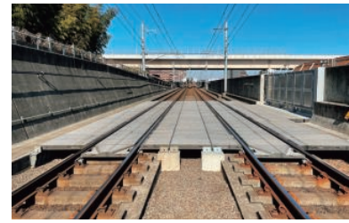
軌陸車進入路 (万博記念公園駅付近の進入路)
