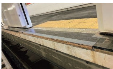
ホーム隙間対策前（柏の葉キャンパス駅）
