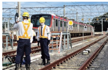
臨時速度情報地上子及び臨時信号機設置
