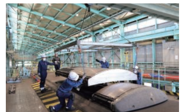
空調装置取外し作業
