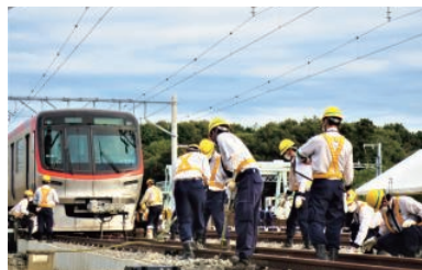
脱線・線路復旧
