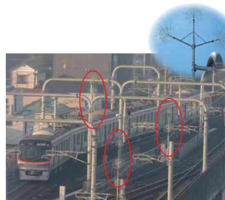
守谷駅に設置している電荷放散器
