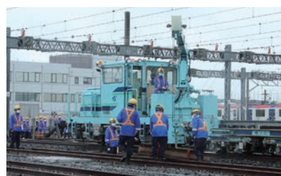
支障物撤去訓練
