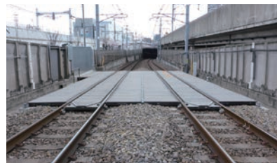
軌陸車進入路 (南千住駅付近の進入路)
