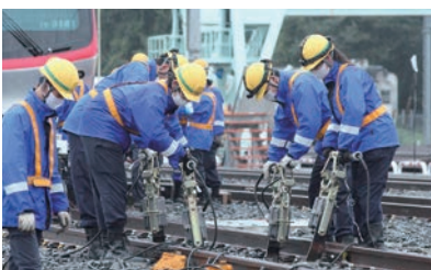
線路復旧訓練
