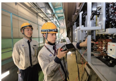
床下機器の検査
