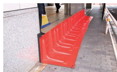
設置例：浸水防止器具（ボックスウォール）
