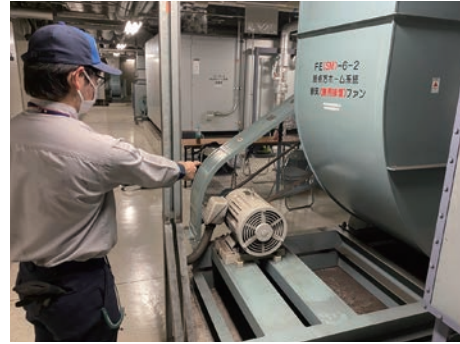
機械設備検査
