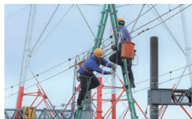
架線復旧訓練
