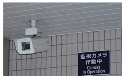
駅構内の監視カメラ
