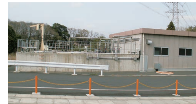
排水処理施設
