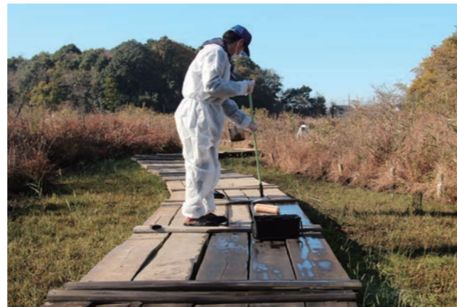
防腐剤塗装作業
