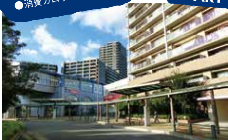
マンションや商業施設などが次々と建設されて、新しく整備された駅前周辺。
