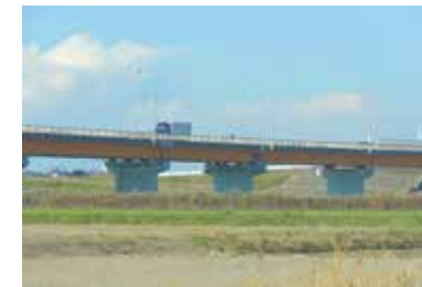
利根川を渡る長大な橋。下り路線側(下流側)に歩道があり、歩いて渡ることができる。
