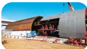
トンネルの実物大実験装置
