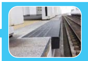
車いす乗降口くし状の隙間対策ゴム
