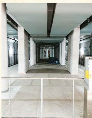
延伸工事(新御徒町駅)
