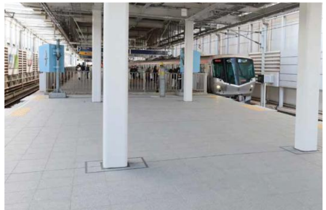
北千住駅ホーム延伸部分(つくば方)
