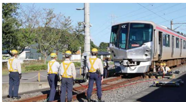
車両係員による脱線復旧
