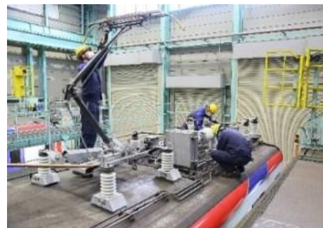
機器の取付確認
