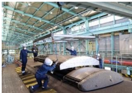
空調装置取外し作業
