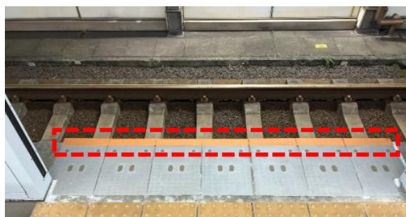
ホーム隙間対策後
