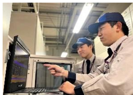
発車標制御装置確認
