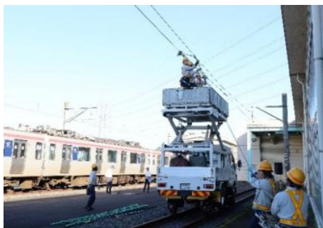
軌陸車を使用した架線復旧訓練
