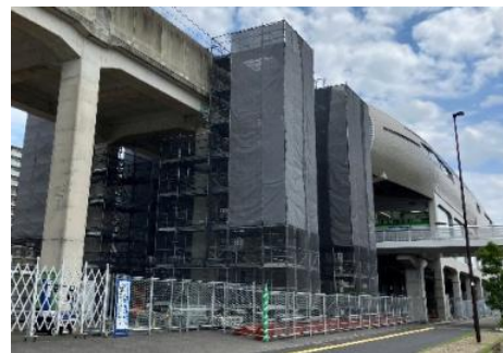
柏たなか駅ホーム延伸工事状況
