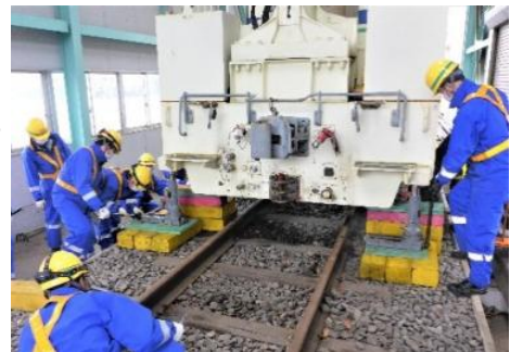
モーターカーの脱線復旧を行う
