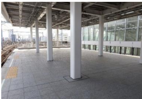
北千住駅のホーム延伸状況
