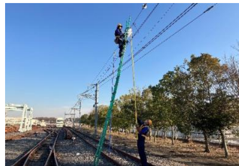
飛来物除去棒を使用しての飛来物除去
