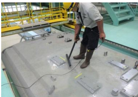
屋根上絶縁材の再塗装
