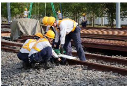
臨時速度情報地上子及び臨時信号機設置
