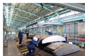
空調装置取外し作業
