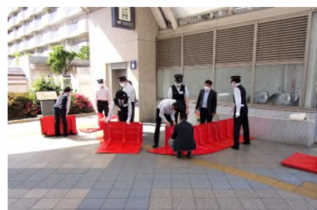
浸水防止器具を設置する係員
