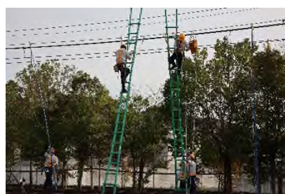
架線断線復旧
