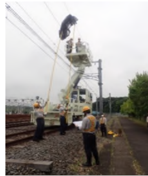
軌陸車を使用しての飛来物除去
