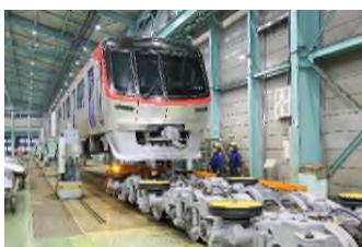
台車の取付作業
