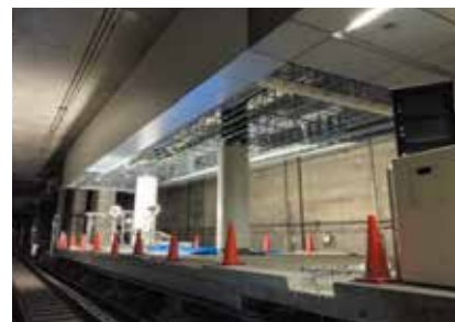
ホーム延伸部分
