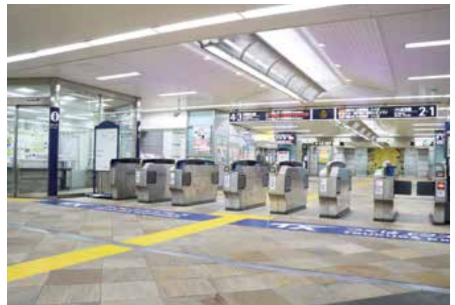
LED化した駅構内コンコース照明(守谷駅改札)
