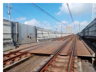
軌陸車進入路 (八潮駅付近の進入路)
