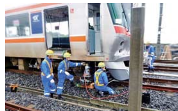
車両脱線復旧訓練
