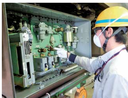
床下機器の検査
