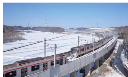
複線化が完成した入出庫線
