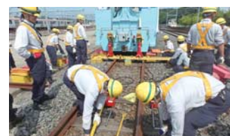
保守用車脱線復旧訓練
