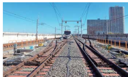
完成した守谷駅追越設備
