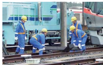
支障物撤去訓練
