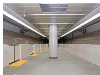
南流山駅ホームの延伸部分
