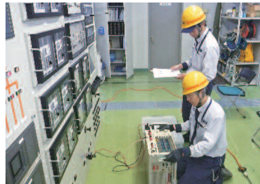
変電所内の点検
