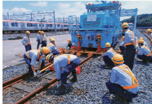
保守用車脱線復旧訓練
