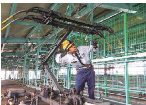
屋根上機器の点検
