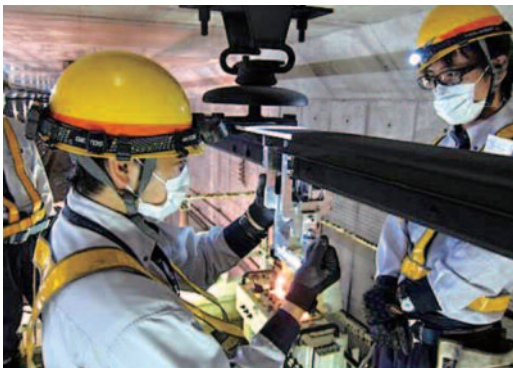
電車線設備の点検
