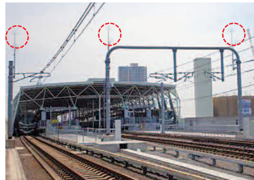
守谷駅に設置された電荷放散器
