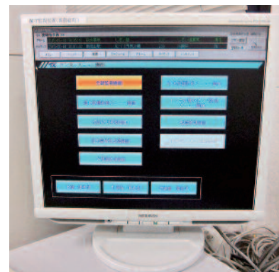
設備集中監視装置モニター画面
