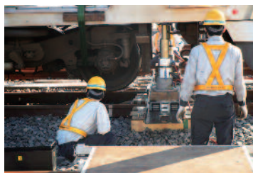
車両脱線復旧訓練
