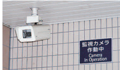
駅構内の監視カメラ
