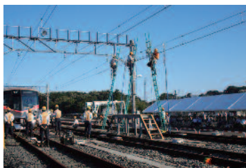
架線断線復旧訓練
