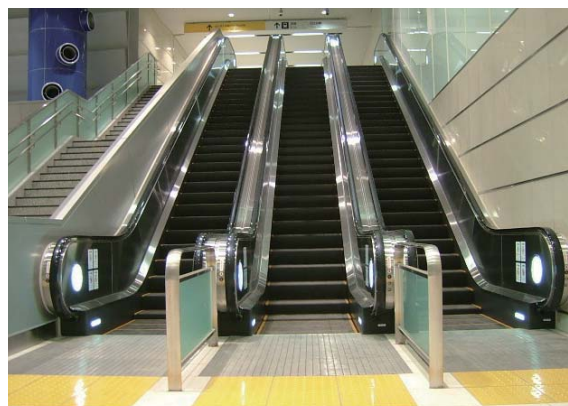
秋葉原駅の可変速度運転エスカレーター
