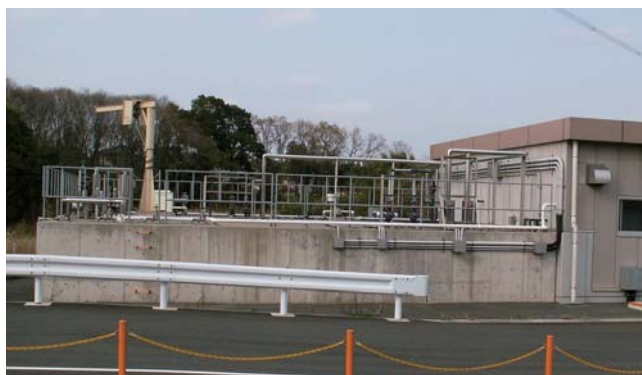
排水処理施設
