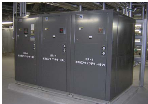
冷水式ブラインチラー（冷房用の冷水を作る装置） 「秋葉原駅」
