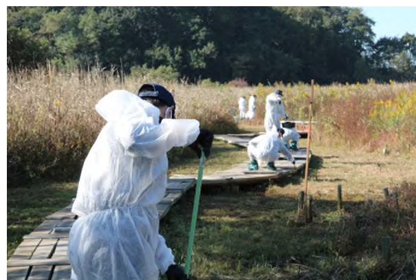
防腐剤塗装作業
