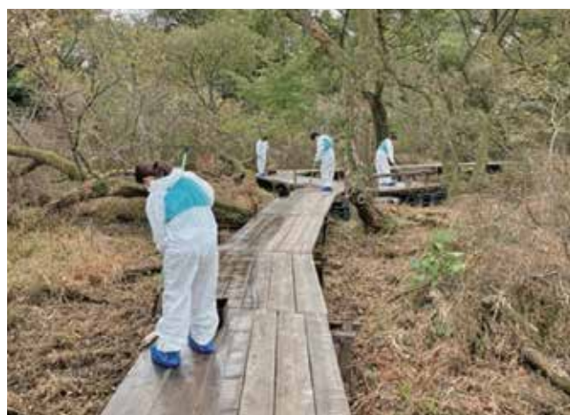
防腐剤塗装の様子
