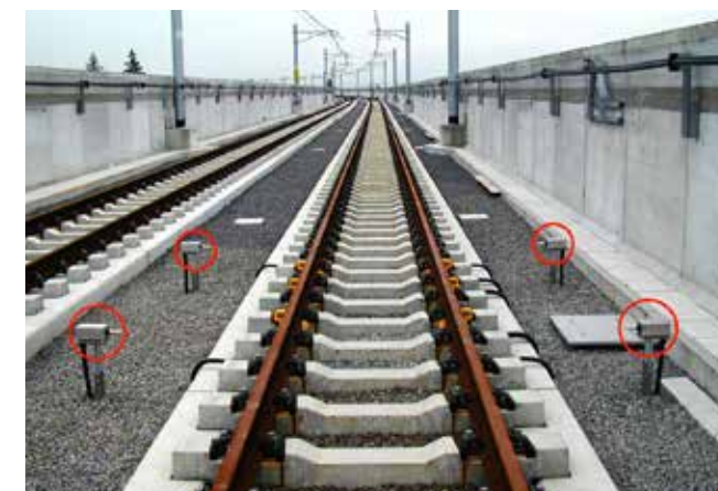
フラット検出装置のセンサー
