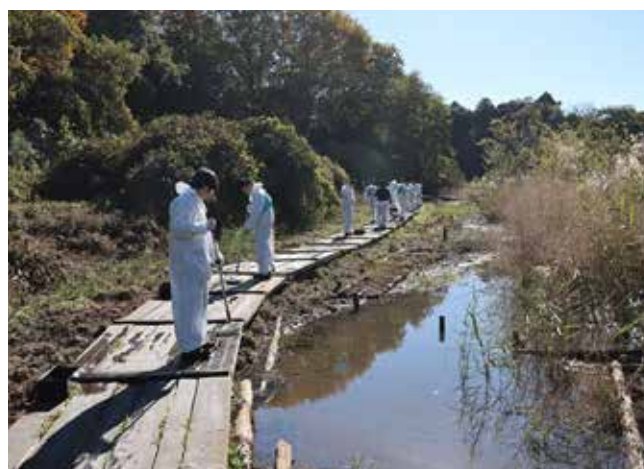
防腐剤塗装の様子
