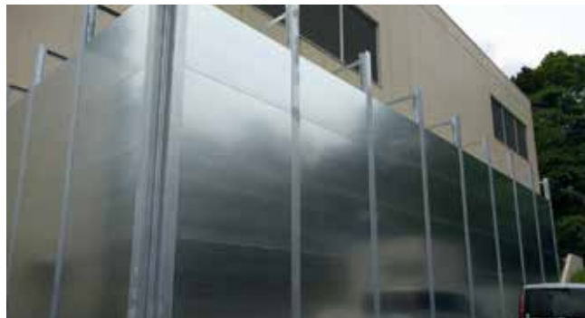
南流山変電所の防音壁
