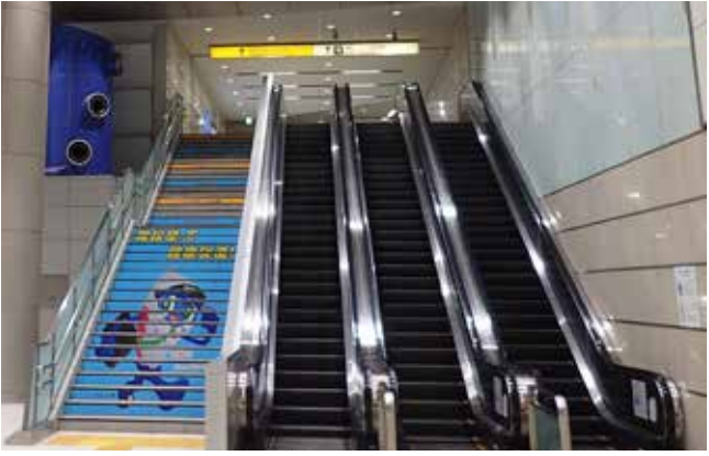
秋葉原駅の可変速度運転エスカレーター
