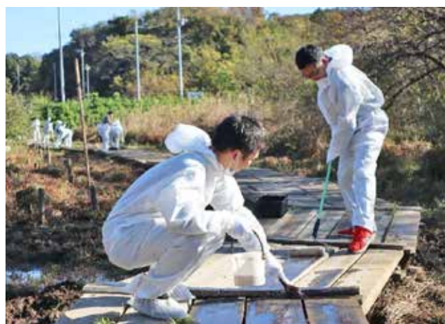
防腐剤塗装の様子
