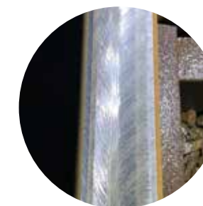
削正後のレール
