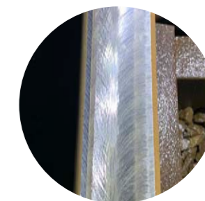
削正後のレール
