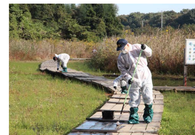
防腐剤塗装作業
