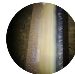
傷んだレール
