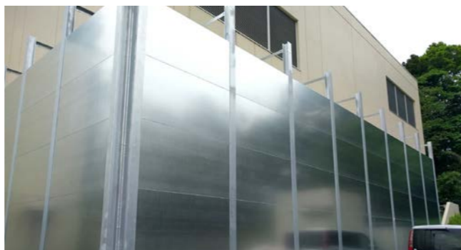
南流山変電所の防音壁
