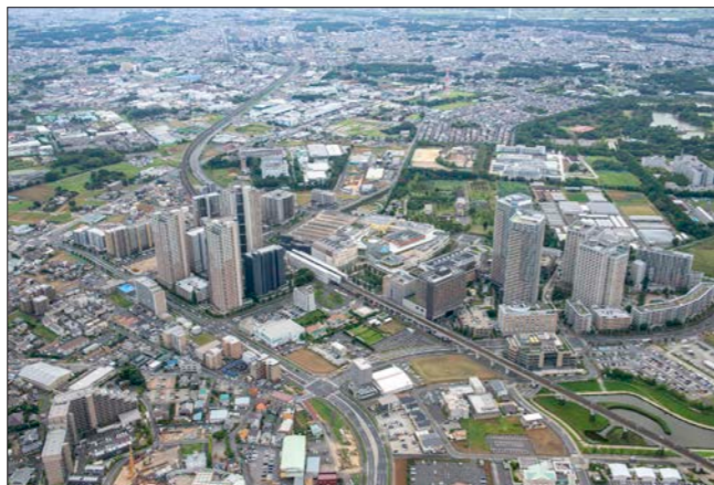
柏の葉キャンパス駅付近の立体交差
