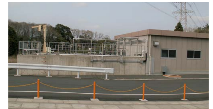
排水処理施設
