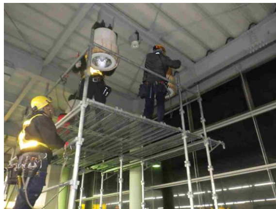
【照明設備交換作業】
