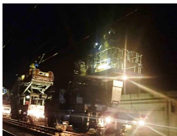
【電車線張替作業】
