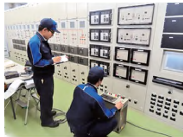
変電所や信号設備の更新
