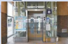
回生電力はTX駅のエレベーターやエスカレーター、冷暖房などに有効利用される
