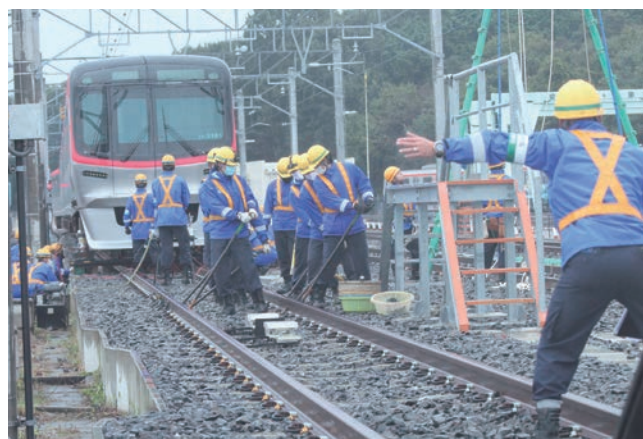
異常時総合訓練の様子(線路復旧訓練)
