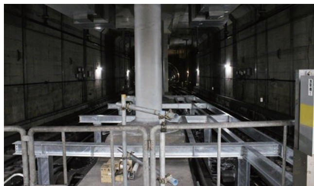
ホーム延伸工事(浅草駅)
