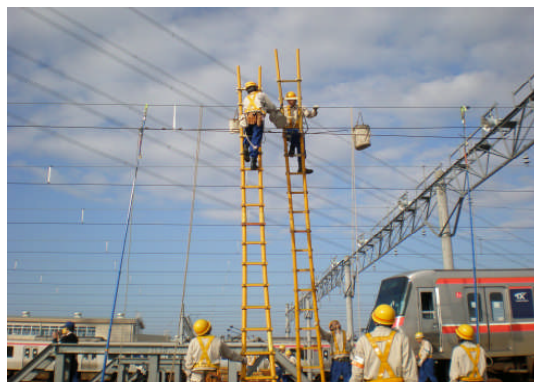
架線断線復旧訓練
