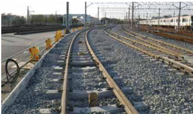
総合基地内に増設工事中の留置線
