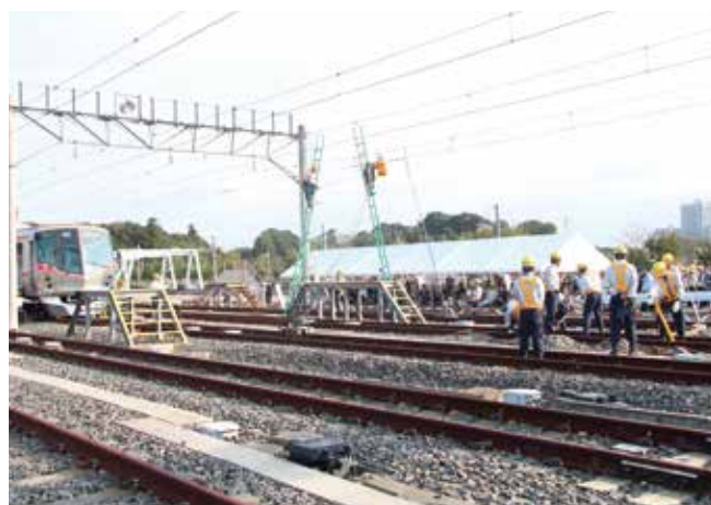
異常時総合訓練の様子（架線断線復旧訓練）
