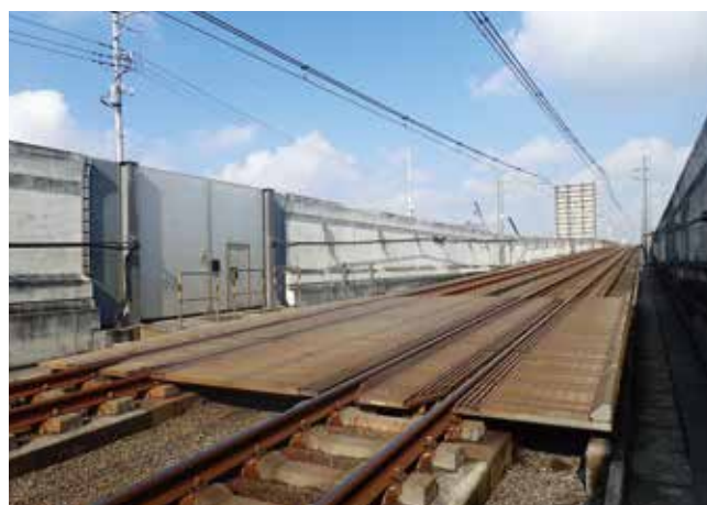
既設の軌陸車の進入路(八潮付近)
