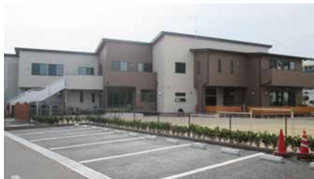
建設中の保育園(流山市)
