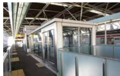
駅ホーム上待合室(守谷駅)
